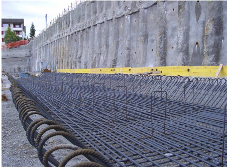
Überbauung Blumenweg, Zug
