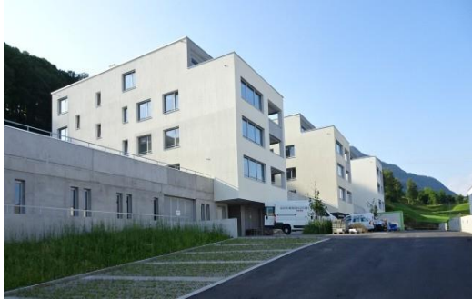
Überbauung Räbmatt, Küssnacht a.R.
